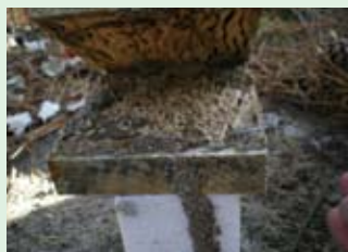
断熱材上、試験片への加害 （設置一年後の2008年12月撮影）
